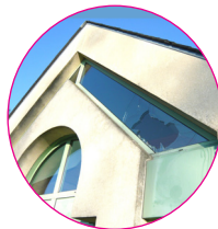
Réhabilitation du complexe sportif
