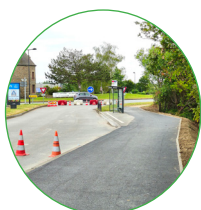
Aménagement cycliste du giratoire du Moulin du Domaine
