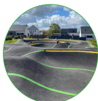
Aménagement du pumptrack
