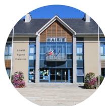
Réaménagement des locaux de la mairie
